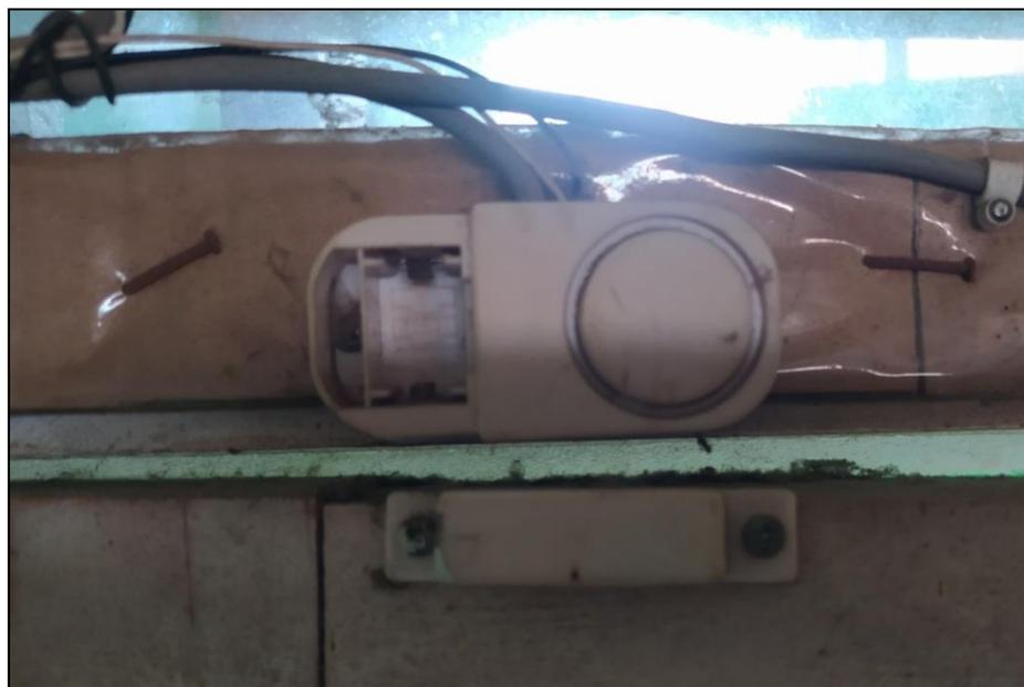
**Gambar 4. 9** *Sensor magnet pada pintu*
